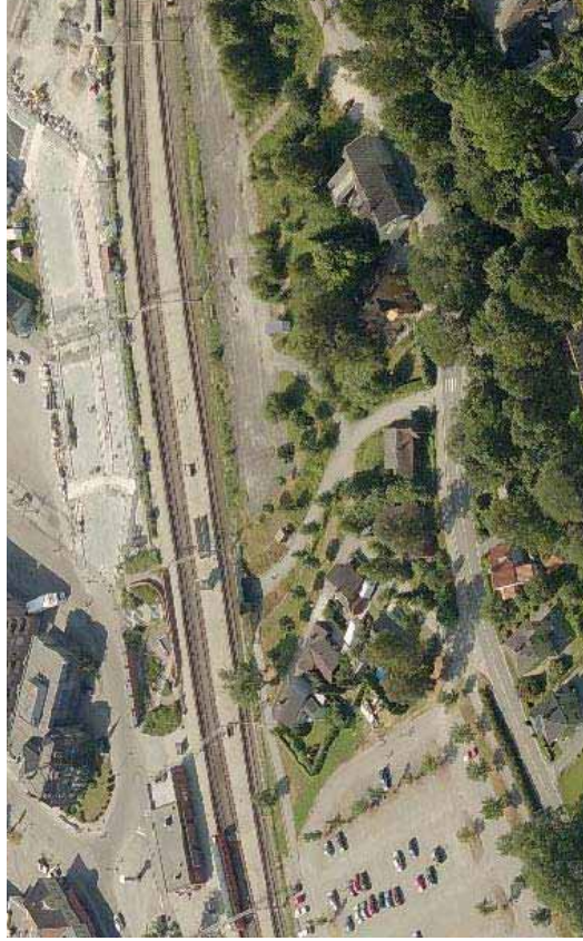
Figur 71. Forbindelsen Kjølnes – sentrum. Jernbaneundergangen med ramper midt i bildet. Se oversiktskart C7
