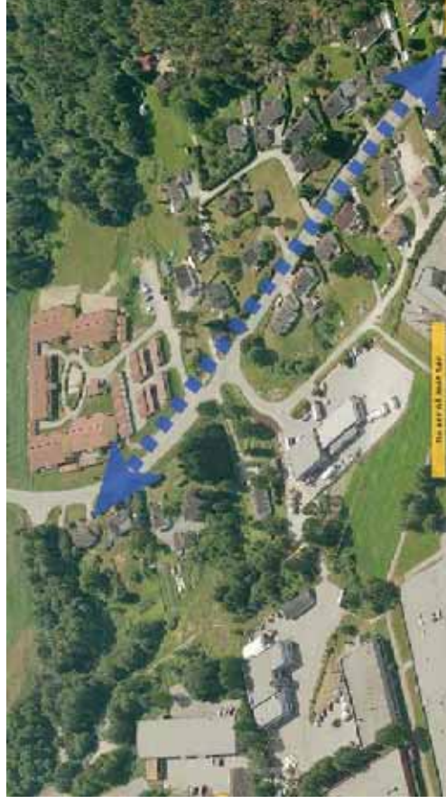
Figur 88. Bjørntvedtvegen sett mot syd. Her foreslås det bygging av gang- og sykkelveg fra nordre avkjøring til Rødmyr til Hulkavegen. Se oversiktskart C6
