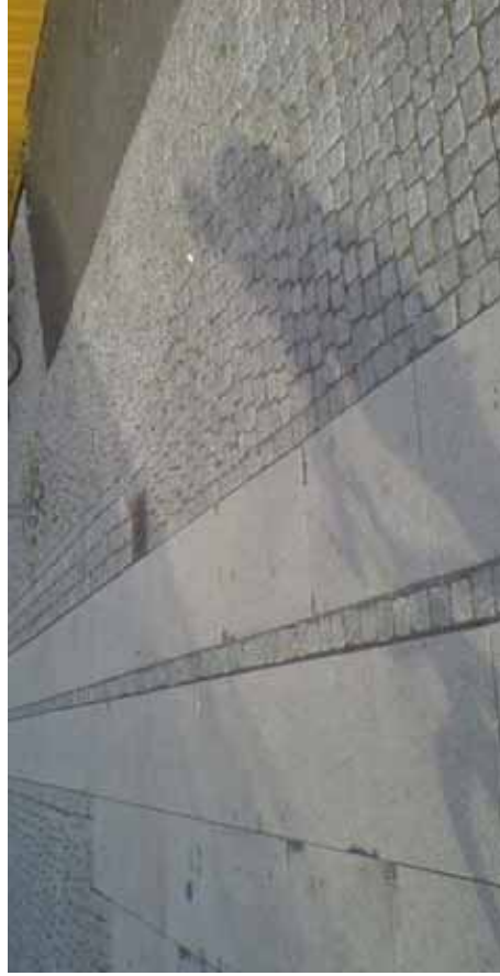
Figur 34. Eksempelf på bruk av heller i sykkelbane i Tønsberg
