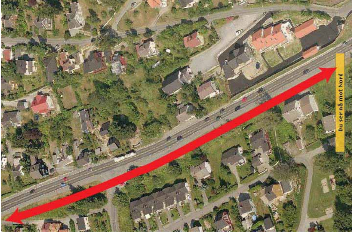
Figur 38. Fra Hammerkrysset til Storgata er det bygd fortau. Se oversiktskart C6 og C7
