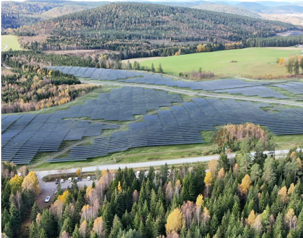
Foto: NVE, Solum solkraftverk
