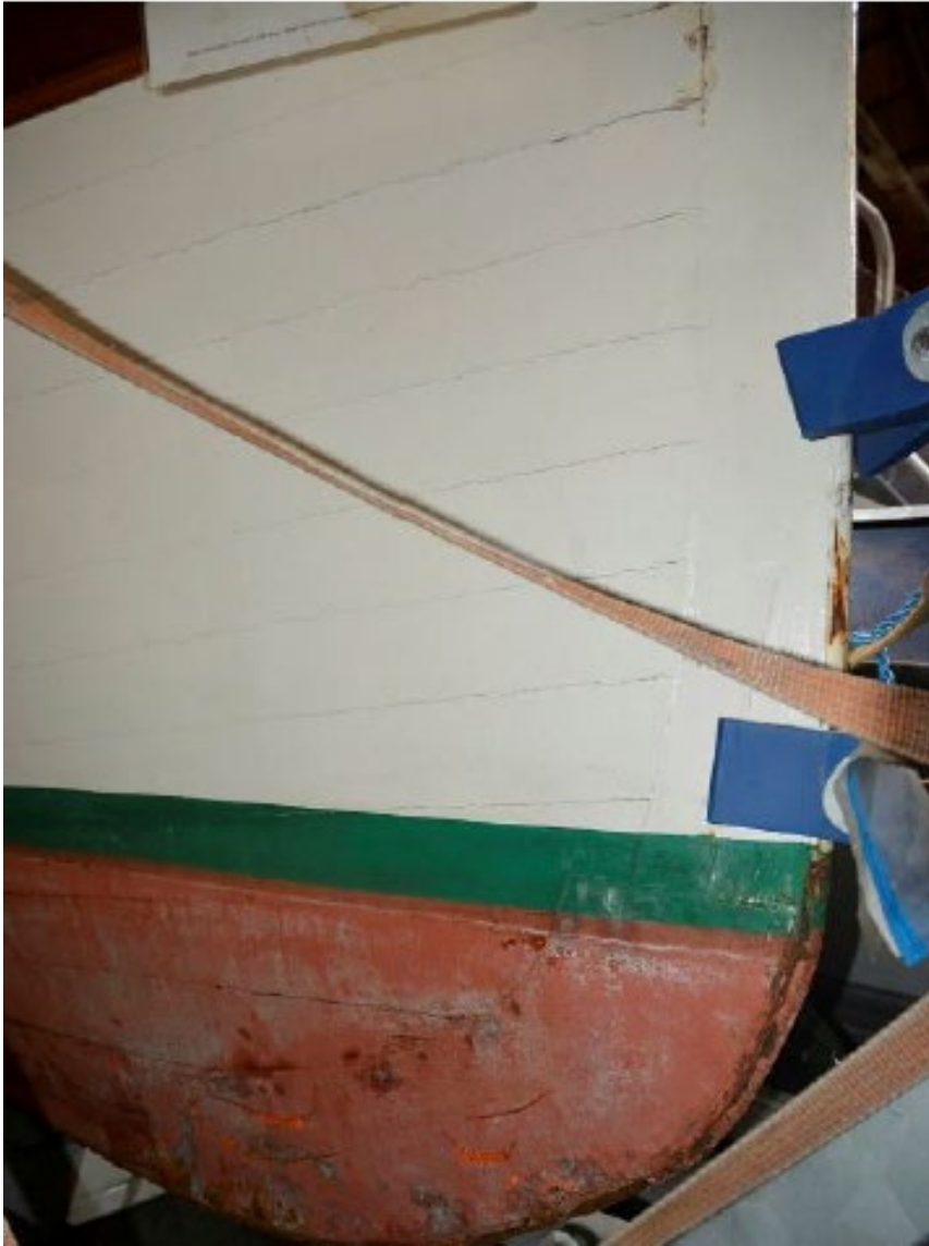
Bilde 23 Utvendig hud i forskipet
