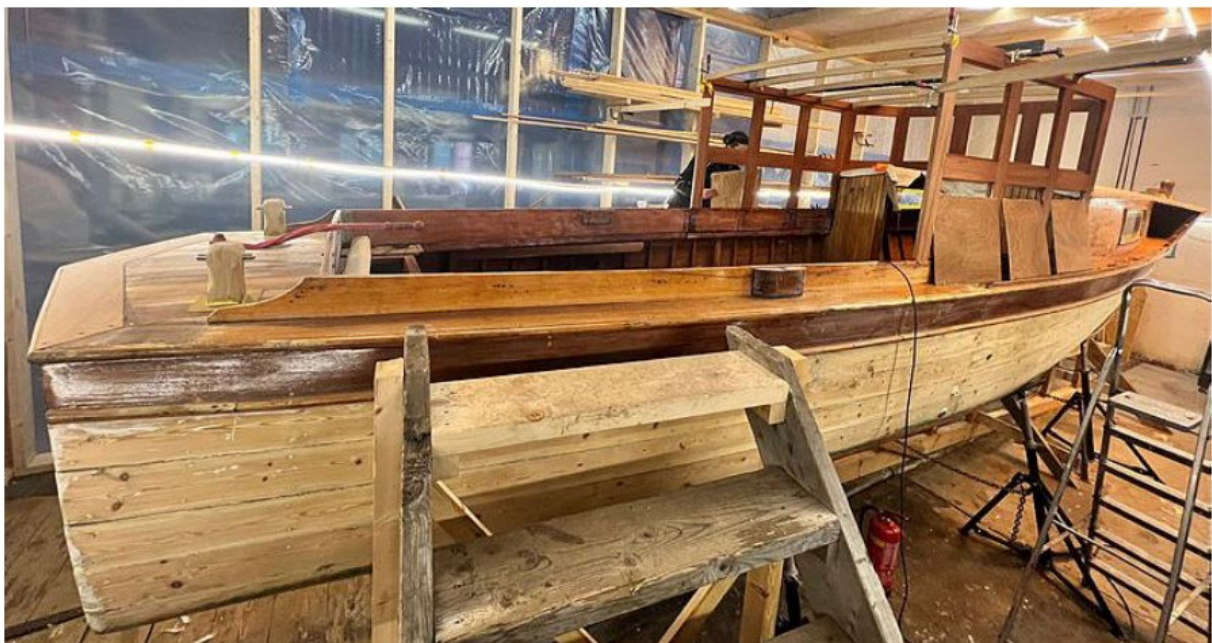
Bilde 38 Viser arbeider med oppbygging av styrhus
