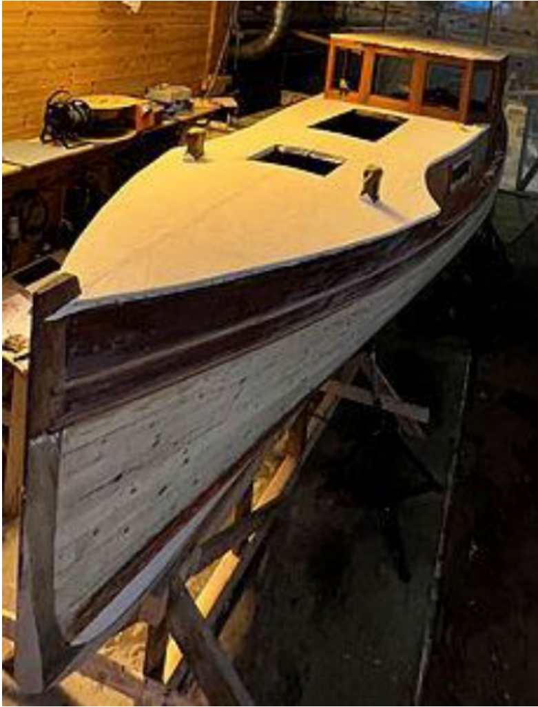
Bilde 39 Seilduken på plass. Panelen på styrehustaket er ferdig spikret og klart for strie, og seilduk.
