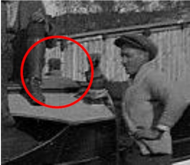
Bilde 15 Opprinnelig pullert på fordekket
