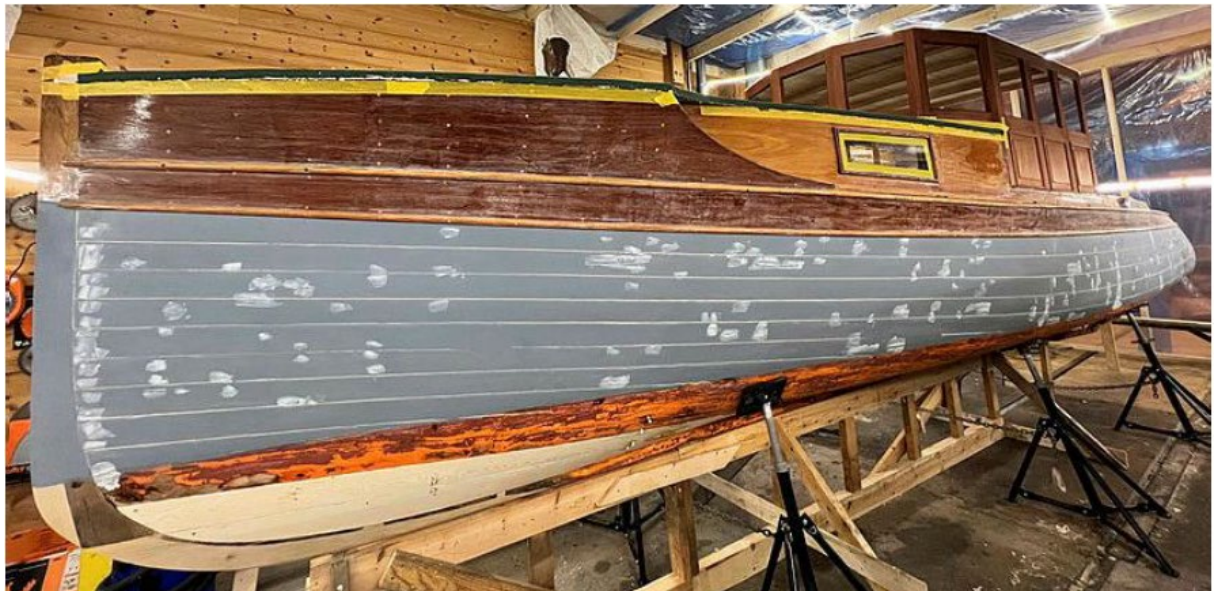
Bilde 41 Seilduken med første strøkk med grønn linoljemaling. Skrpget er sparklet og nat er kittet. Kjølen reparert og spunset for skade etter grunnstøtingen som skjedde året 1398. Styrehus er ferdig limt og montert takbjelker hvor fyllingene (speil) er på plass i styrehuset.
