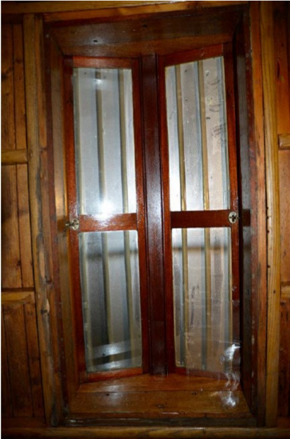
Bilde 30 Skylight sett fra salongen
