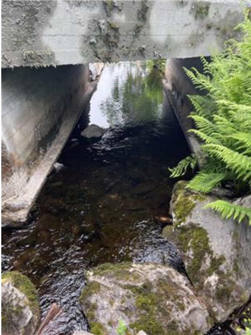
Figur 18. Naturlig bunnsstrat i bekken under broen langs Brynesteinvegen der den krysser Eidsborgtjernbekken.
