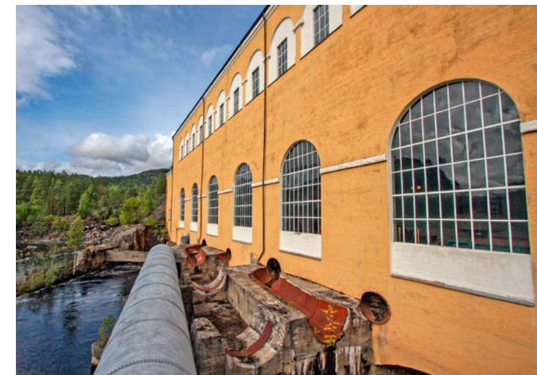
Høgefoss kraftstasjon med rørgate. Foto: Eystein M. Andersen, Telemark fylkeskommune
