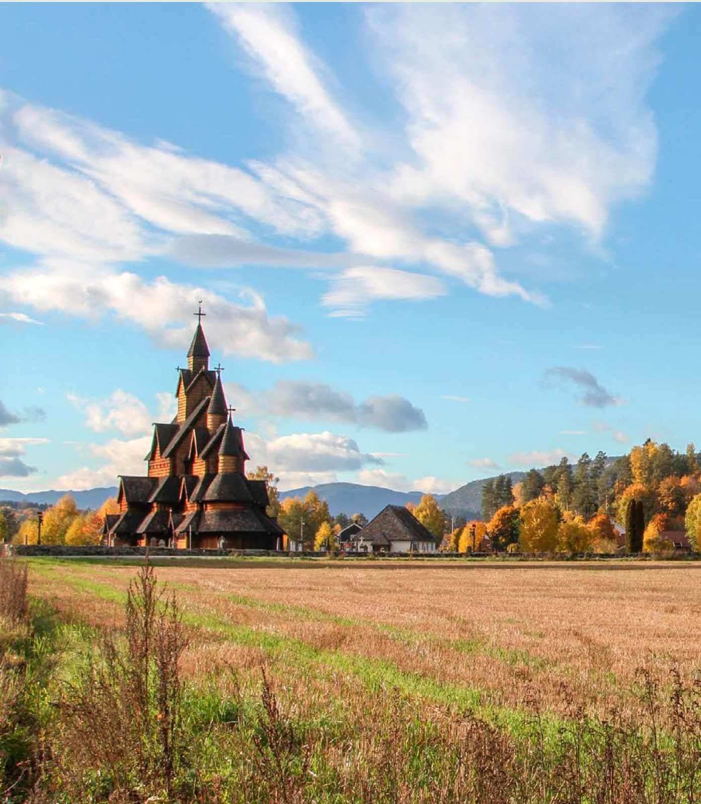
Det kulturhistoriske landskapet Heddal har utgangspunkt i Heddal stavkirke, tidligere Rygin kirke etter gården Ryen. Det omfatter kirkestedet og omkringliggende landskapsrom. Landskapet er et åpent jordbrukslandskap med en struktur og organisering som kan følges tilbake til middelalderen. Det er rikt på kulturminner fra jernalderen og fram til i dag. Foto: Rune Nordseter, Telemark Fylkeskommune
