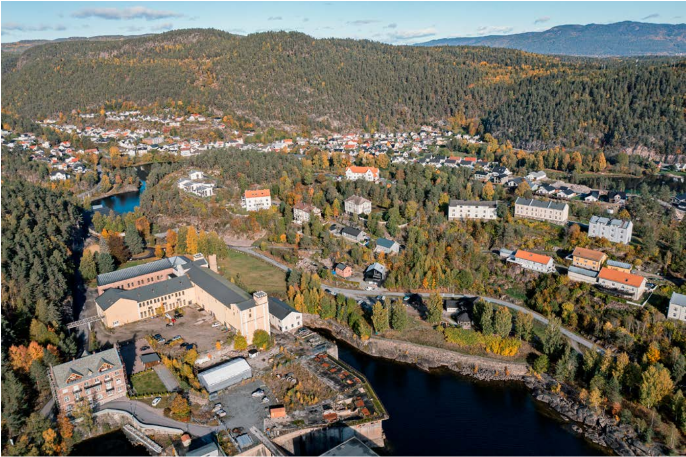
Skotfoss med fabrikkområdet og kraftanlegg. Foto: Rune Nordseter, Telemark fylkeskommune
